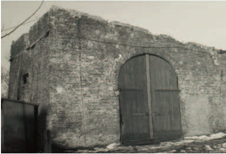
Na de brand in 1927 restte er alleen nog een stenen romp van de Houtse molen. De molen lag aan de Mierloseweg tegenover houthandel Raijmakers. (collectie RHCE)
